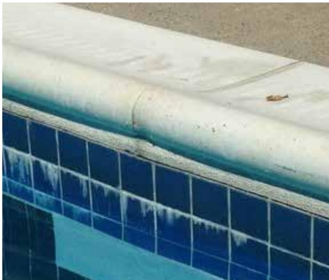
Como podemos ver en la fotografía, la disolución de las juntas de gresite se transforma, tras la evaporación del agua que mojaba la pared, en una marca blanca de "incrustación", es decir, el calcio que teníamos en el interior de la junta, lo sacamos al exterior por acción del agua agresiva dejándolo depositado en la superficie del gresite, dando esa imagen de descuido.
