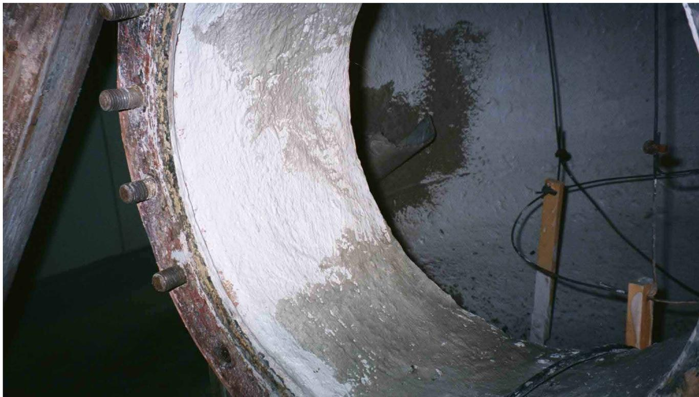
El único modo de evitar en todos los casos dichos problemas en los depósitos nuevos, garantizando que se mantendrá el interior de estos limpio y sin óxido, es construirlos según se indica en la norma UNE 112076 e instalar en ellos un sistema de protección catódica según la norma UNE-EN 12499.
